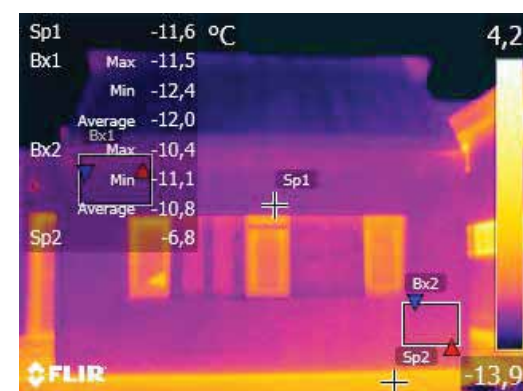
Slika 3: Termo posnetek JUBHome hiše
