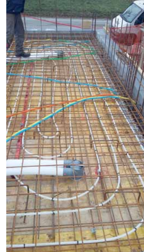
Slika 4: Razvod hladilnega sistema
